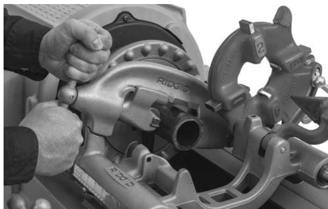
Рис. 21 – Резка трубы с помощью трубореза
